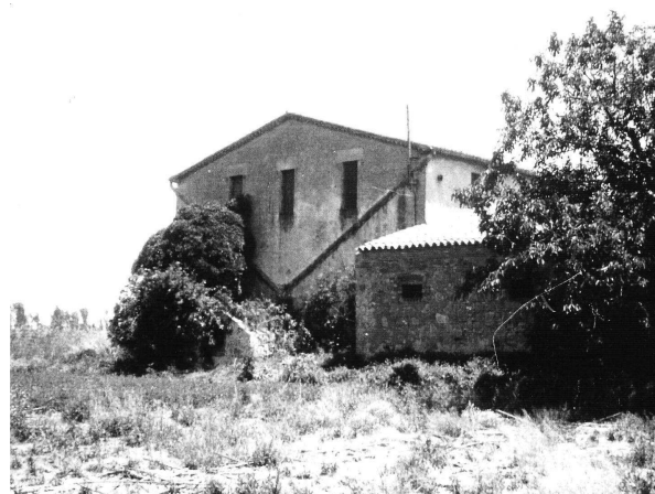
Figura 5. Vista de la cisterna de Cal Dominguet (avui desapareguda)
