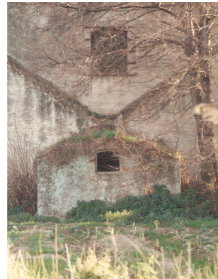
Figura 4. Cisterna de la masia de Cal Monés.
