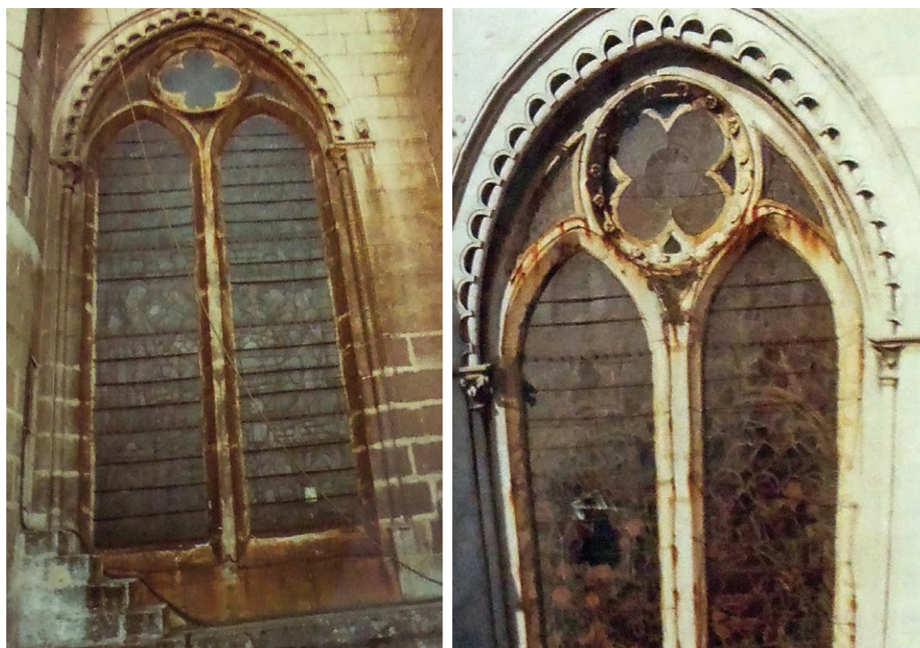
Las fotografías de las vidrieras de la nave del altar mayor y transversales 556 (Nº 27 y 30, respec- tivamente) muestran los restos de las protección de las antiguas alambradas exteriores, cuya corrosión había manchado la piedra. Fotografías: Rico Santamaría, M. (1982)
