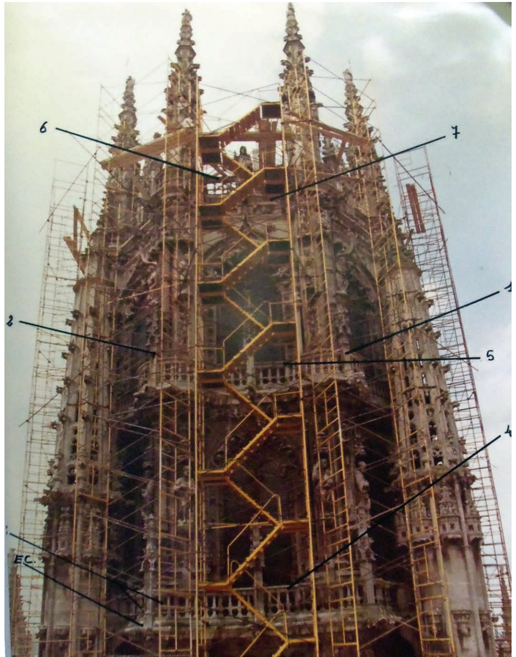
Linterna del crucero. Fachada frente a la capilla del Condestable. Indicación piezas a restaurar. Fotografía: Rico Santamaría, M. (1983)
