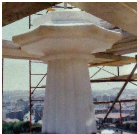
Torrecilla nº 1. Reposición total de la piedra de la peana del ángel de remate.
