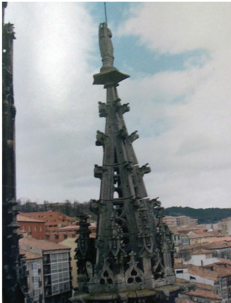
Chapitel del husillo de la Sacristía. “Las cuatro piezas superiores y el ángel están sólo sostenidas por el eje de hierro, apoyándose en las opuestas. Es preciso el desmonte casi total del chapitel restaurarle sin piedra nueva y montaje restaurado con nuevos ejes y resinas especiales” . Fotografía: Rico Santamaría, M. (1985)
