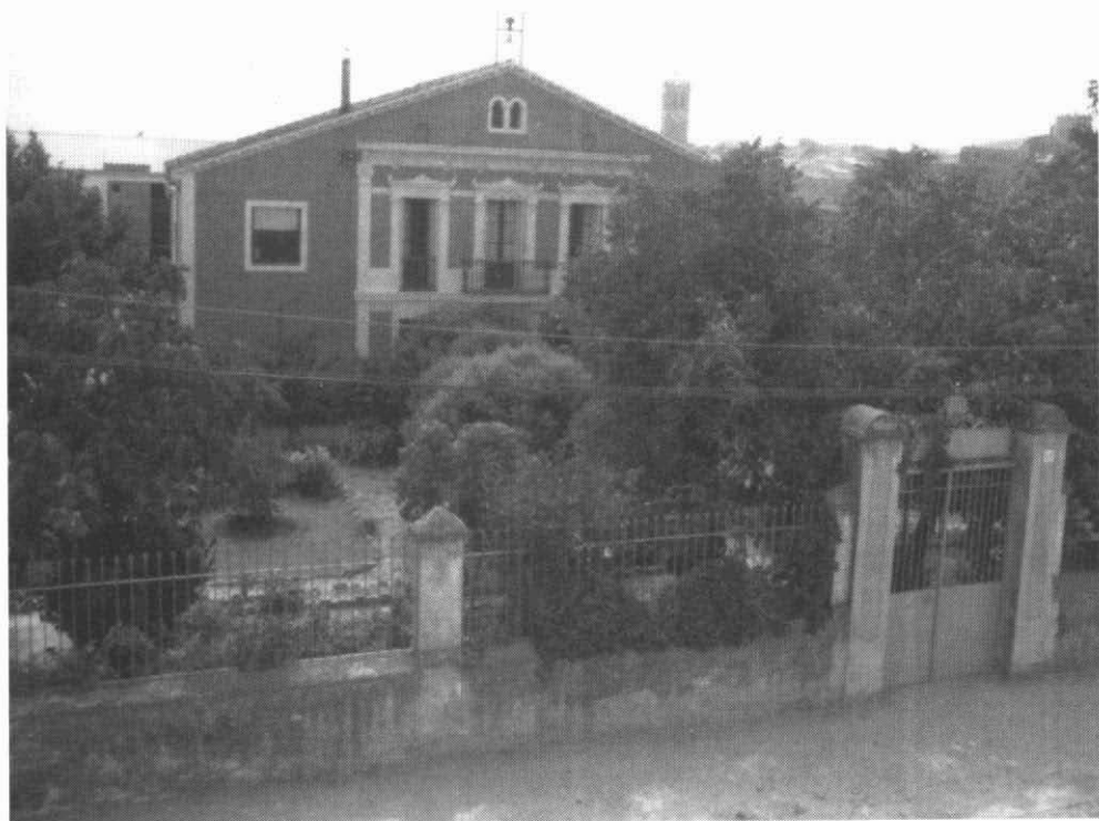
Aspecte exterior de "La Torre", adquirida per l'Ajuntament el 1922 i més tard destinada a Casa de Salut. Foto cedida per la Comunitat de Germanes.
